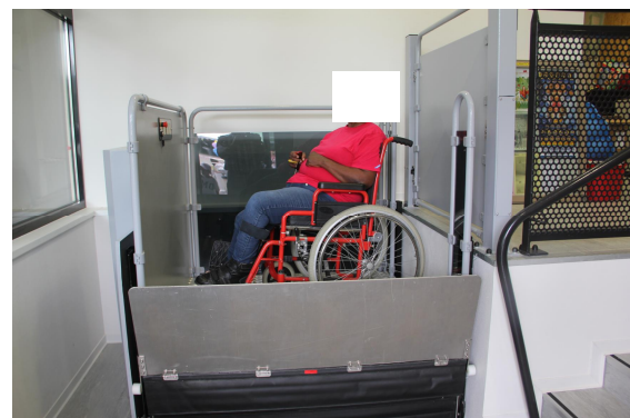
Rampe d'accès pour personne à mobilité
